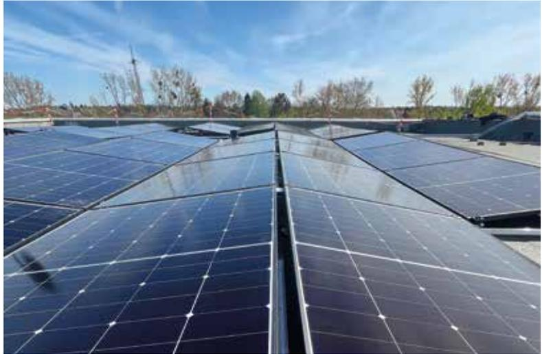
Im Bau befindliche Photovoltaikanlage auf dem Dach des CAZ St. Bruno mit einer Leistung von ca. 99,88 kWp und einer jährlichen Stromproduktion von rund 90.000 kWh.
