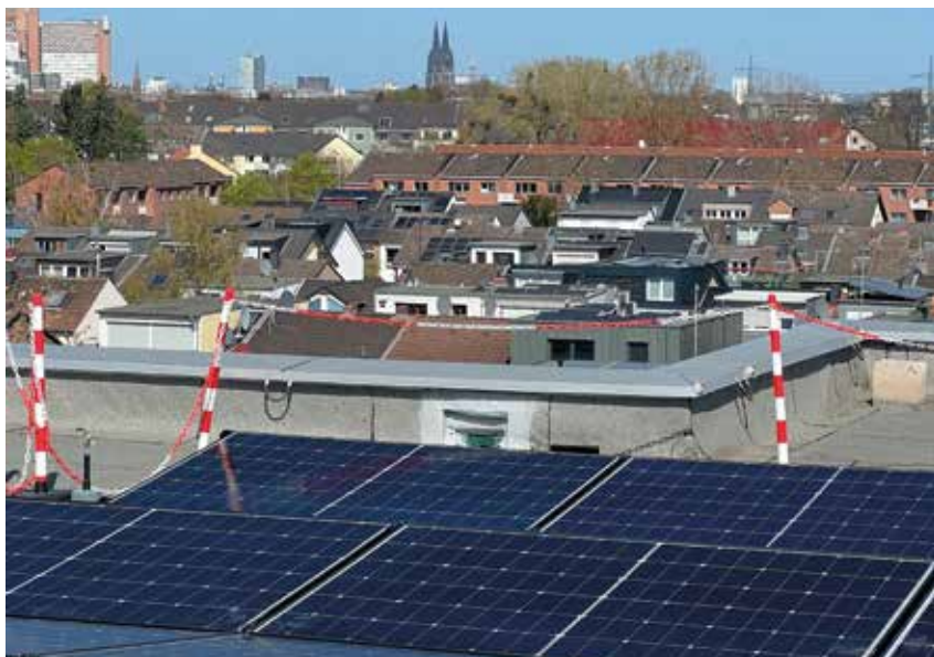
Auf dem Dach des Caritas-Altenzentrums St. Bruno in Klettenberg produziert eine Photovoltaik-Anlage Strom.
